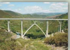
Ensayo en puentes
